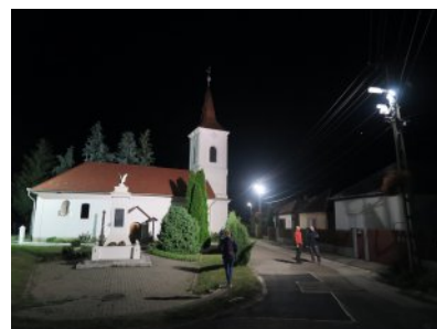
5.3. kép. Műemlék templom 4 db 250 W-os CMS fényvetővel előidézett túlvilágítása jelentős fényszennyezést eredményez.
