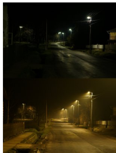
5.12. ábra Közvilágítás Bárdudvarnokon csere előtt és után. Javult a világítás minősége és csökkent a fényszennyezés.
