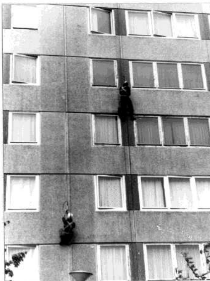
14. Munka közben a panelházon.
