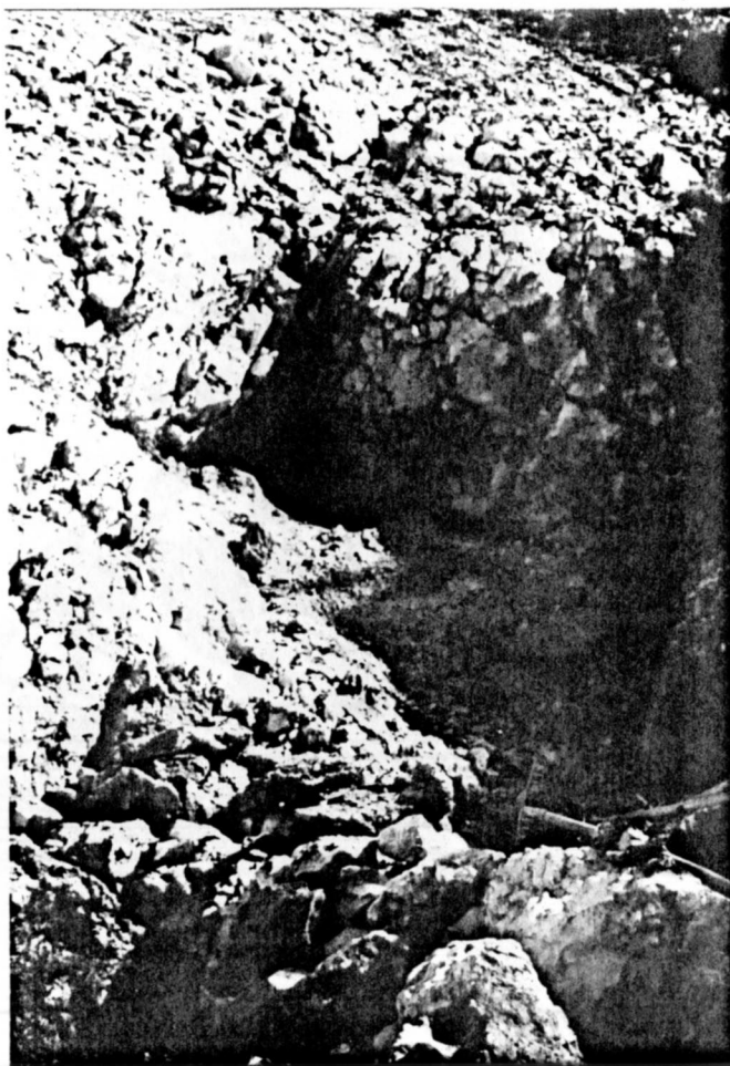
Az új bejárat helye a bontás kezdeti szakaszán.
