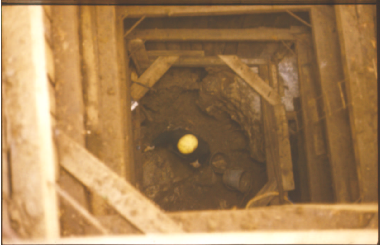
Betonzás előtt a harmadik ácsolat
