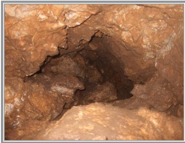
Ilyen volt bontás előtt a felső végpont
