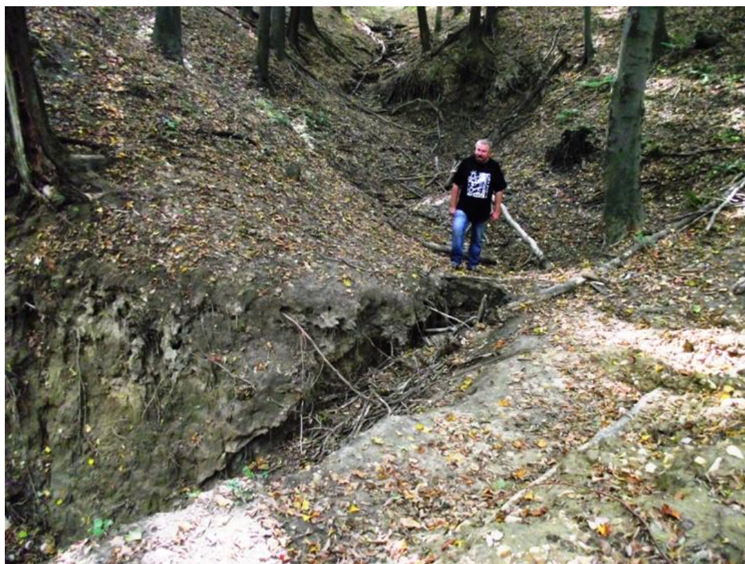
A nyelő löszkitöltésében a barlangbejáratához vezető árok.
