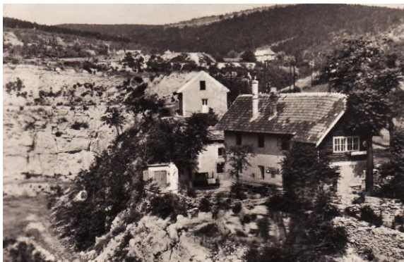
9.3. A kőfejtő melletti épületek egykor
