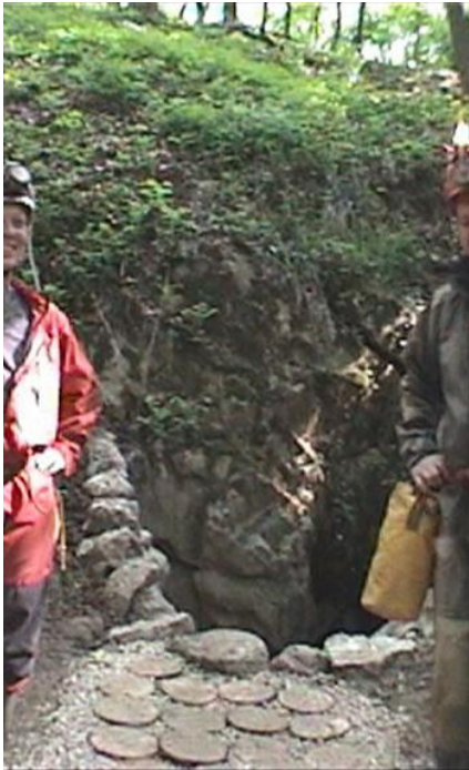
Kőművesmunka a bejárat kiépítésekor.
