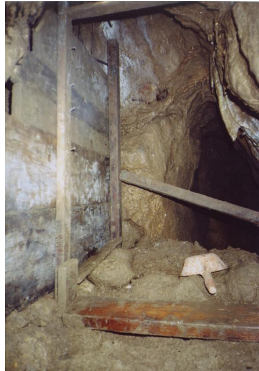
A bezsaluzott átjáró betonozás közben.
