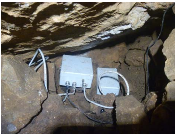
6. kép: Cavemon vízszintmérő műszer elhelyezése
