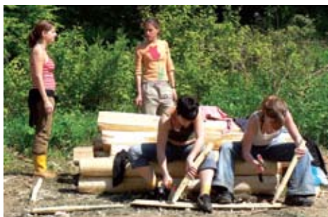
Tanösvény építése (Vác)
