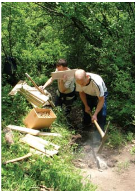
Tanösvény építése (Kömloska)
