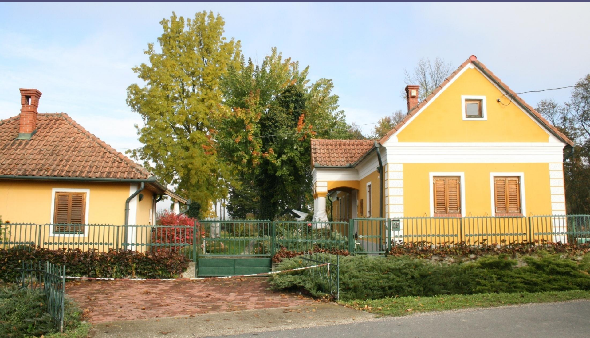
Zalaszombatfa - felújított népi lakóház és udvara
