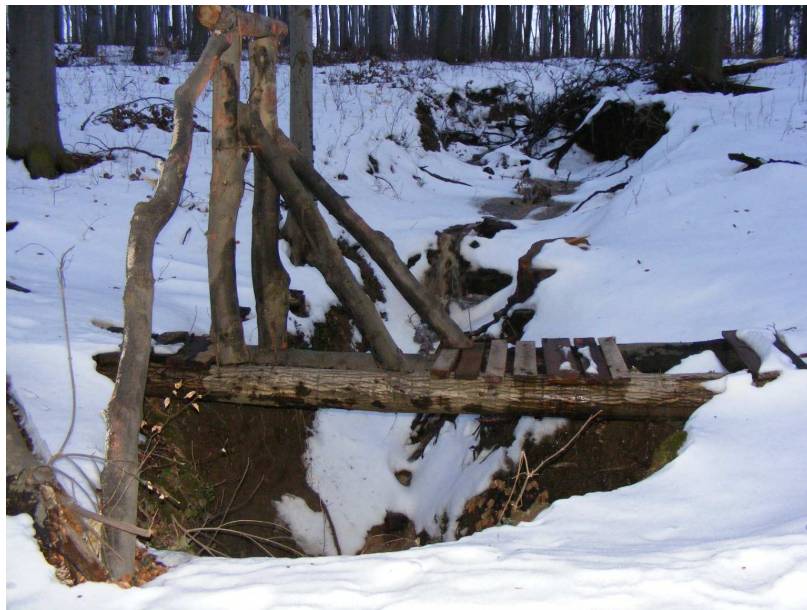
A felújított csörlőállás a Tulok-álma-zsombolynál (Fotó: Kocsis Ákos)
