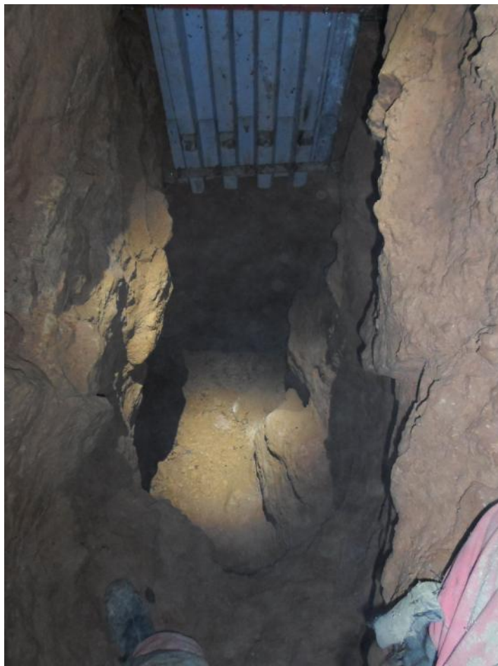
A lecsökkentett szelvényben mélyített akna alja
