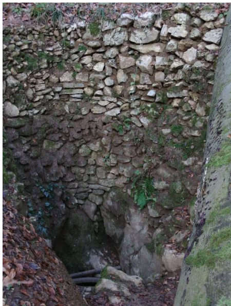
1. melléklet Felső-forrási- beszakadás bejárata
