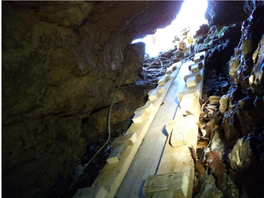
10. sz. fotó: A felhúzó csúszda egy mozdulattal átalakítható biztonságosan használható mászó-létrává, mely nagyban segíti a barlangból történő gyors kijutást (fotó. Kocsis Gergely)
