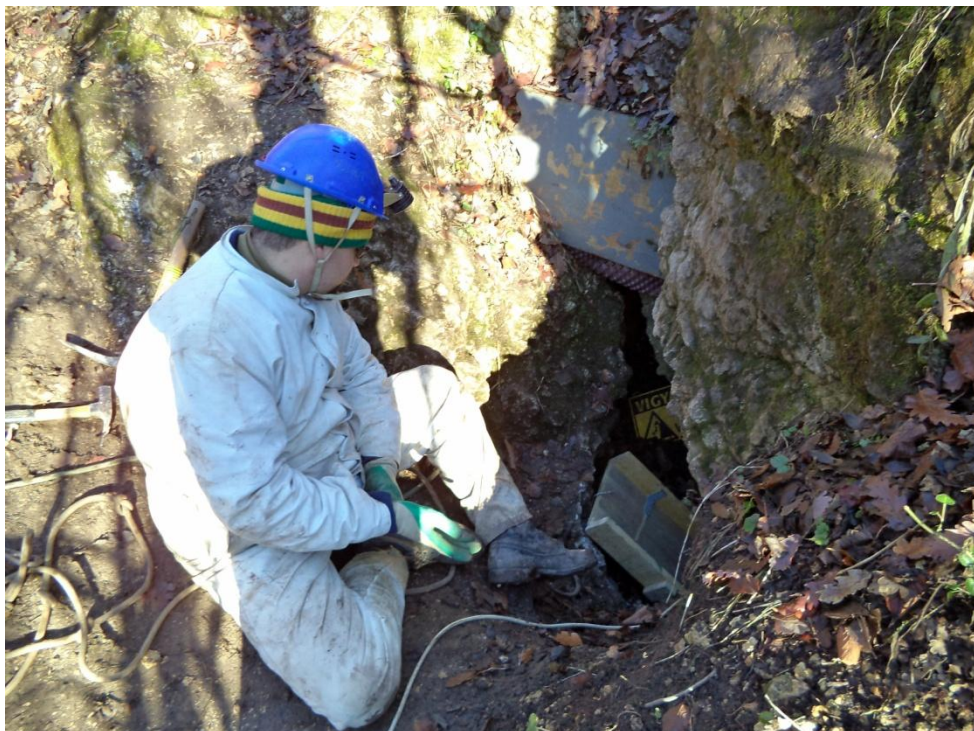
9. sz. fotó: a bejáratnál lejtaknába egy ötletes szerkezetet építettünk, mely a kutatás időtartama alatt kettős funkciót lát el. A képen éppen felhúzó csúszdaként funkcionál (fotó: Kocsis Gergely).
