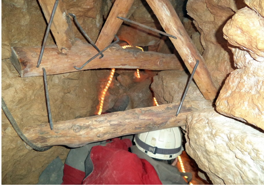
6. sz. fotó: A jelenlegi végponton folyó kutatások biztonsága érdekében vörösfenyőből készült ideiglenes ácsolatot építettünk be (fotó: Molnár Balázs)
