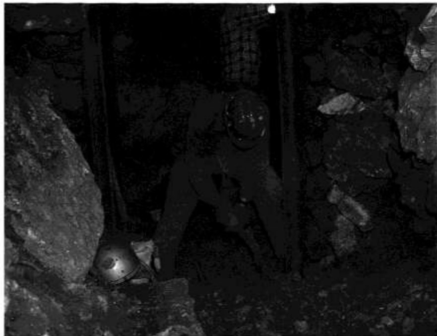
Csille-palya kiépítése a Kossuth-barlang bejárati tárójában az első TH-keret beépítése során.
