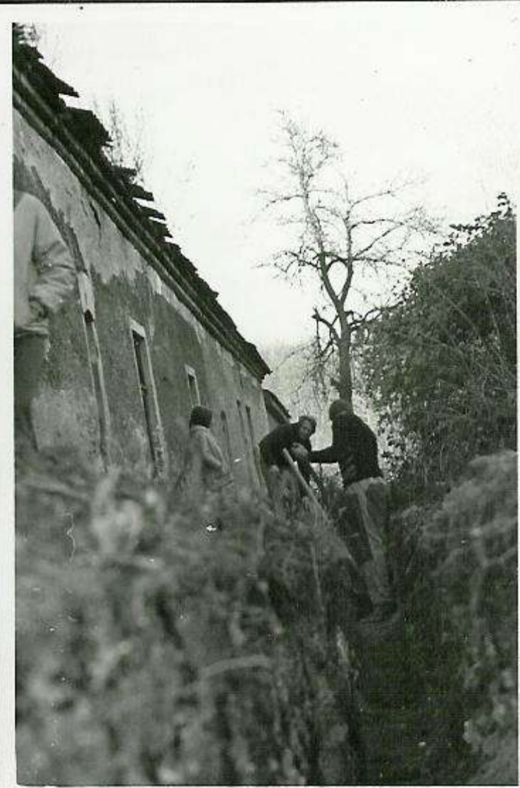
Épül a vízvezeték
