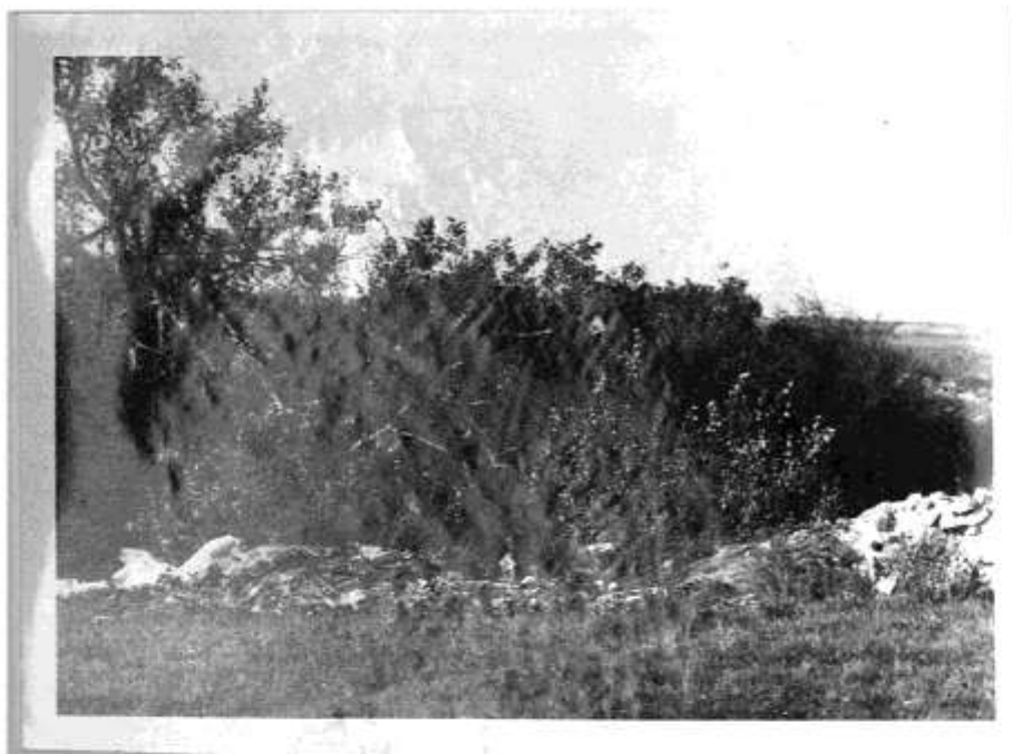
2. ábra. A H-1-es víznyelő, környékén építési törmelék látszik
