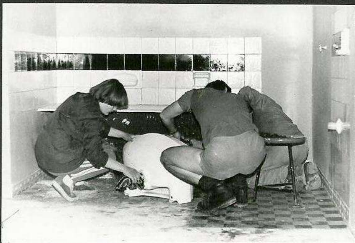
Szerelvények beépítése /Z/
