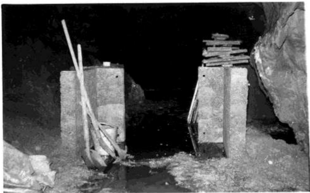
A retek-ági bukó a betonozási munkák befe- jezése után
