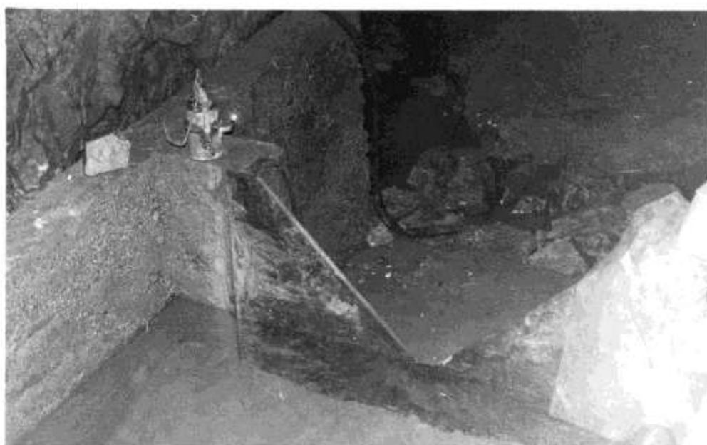
A Retek-ágban elhelyezett Thomson-bukó, működés közben
