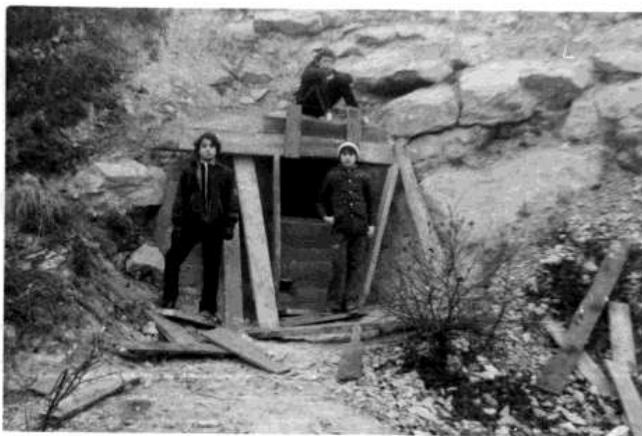
Róka-hegyi-barlang. Készül a felsőrész zsaluzása. /Tihanyi/
