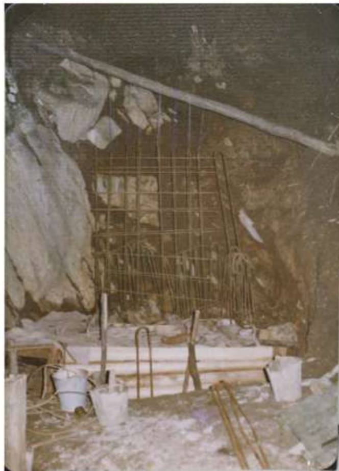
Az új bejárat térfalának vasbeton szerkezete
