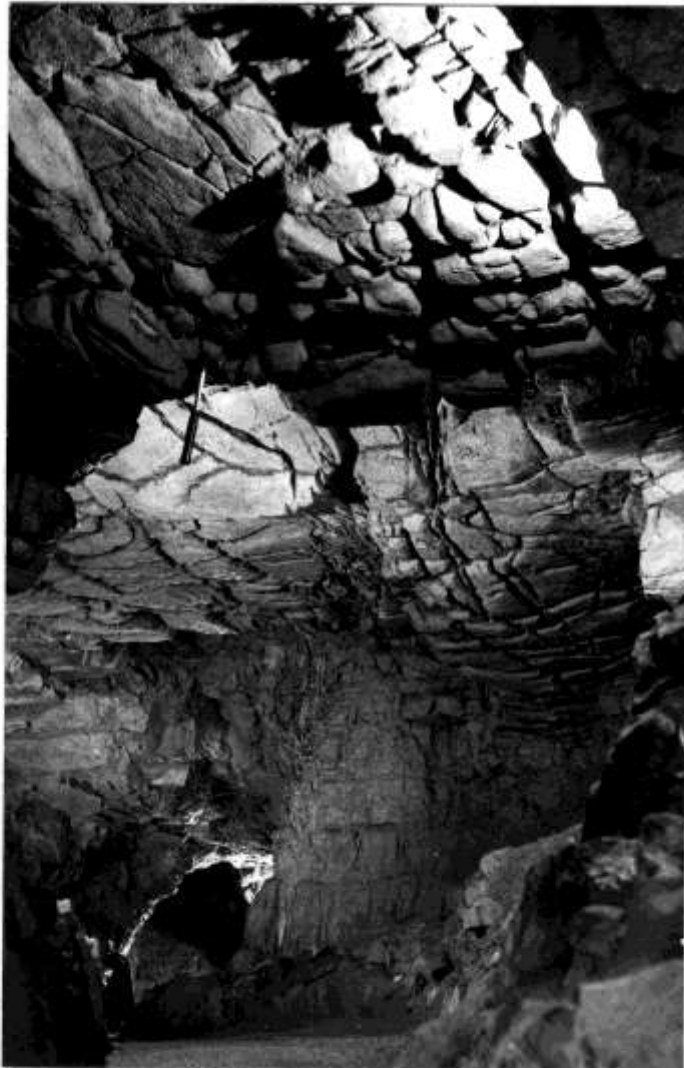
Repedéshálózat mentén kioldódott menyezetrész a Jósvalfői szakaszon
