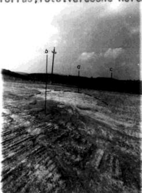
27. ábra: A Gy-11/b. jelű víznyelő melletti beroskadás feltöltődése az 1980.5.9-i esőzés hatására /a. beroskadás pereme, b. iszapkitöltés, c. űregfolyás, fotó: Veressné Herczegh K./
