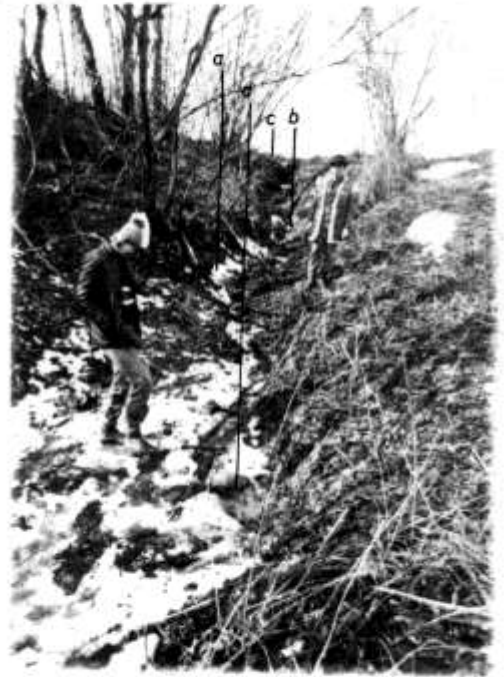
26. ábra: Vízlelővírgáts a G-1. jelű víznyelőben /a. nyelő kitöltésében 1979-80-ban kialakult meder, b. a meder vízének elszivárgási helye, c. a meder beomladozó vége, d. a tavasz folyamán észlelt szivárgási hely, fotó: Veressné Herczegh K./
