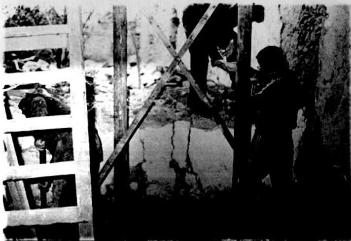
6.ábra: A megsérült fal helyreállítása /fotó: Böröcz M./
