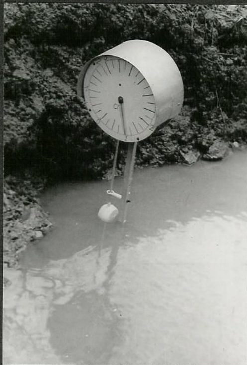
A tizszeres nagyítású vizhozammérő... /Z/
