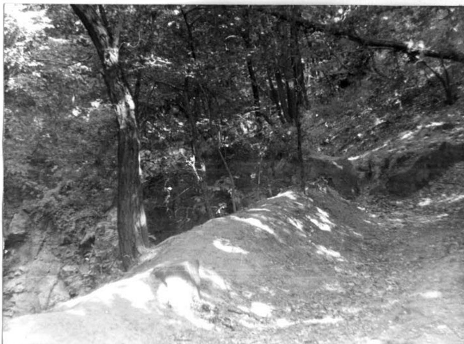
Az elődök keleti elvezető csatornája (agyagosított, stabil ← védőgát )
