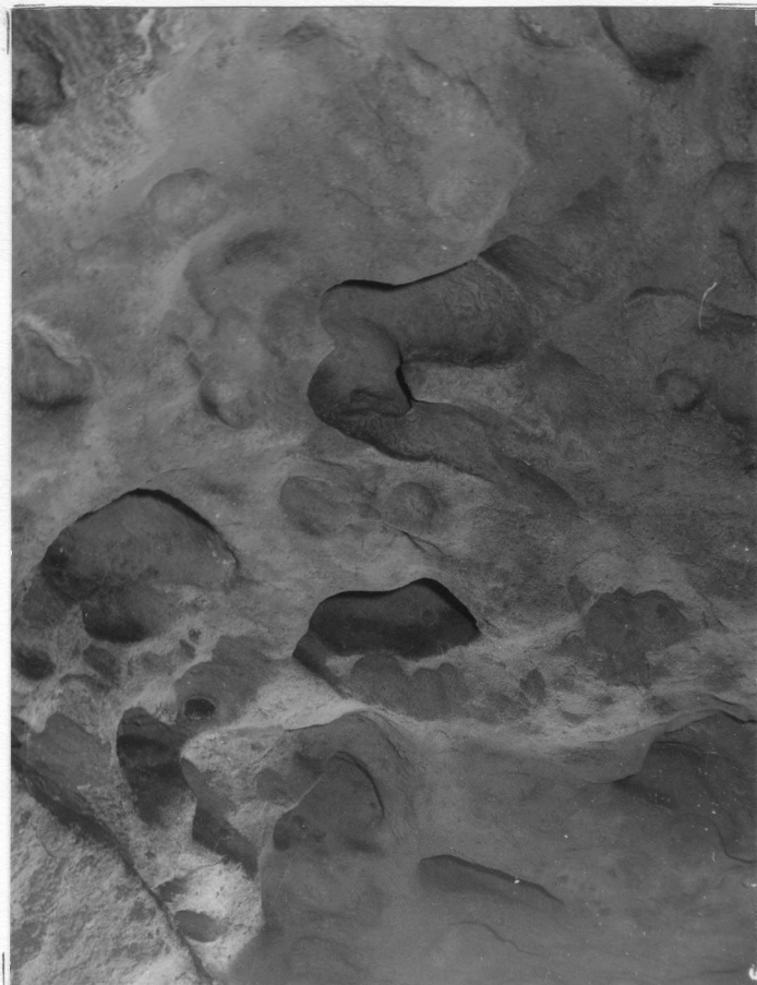
A Peti-folyosó ferde főtégikjének gázcsatornája
