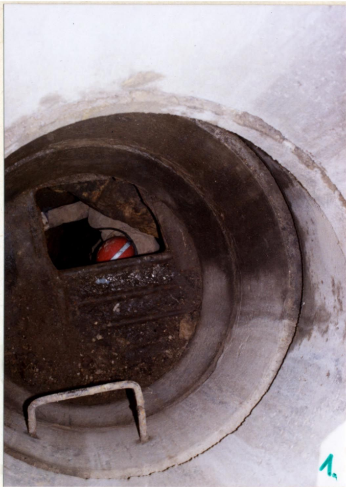
Vasbeton körgyűrűs bejáratbiztosítás.
