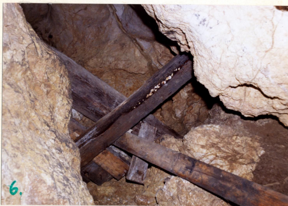
A depóácsolat alulnézetben, jobbra tőle az előbbi járatkitöltés.
