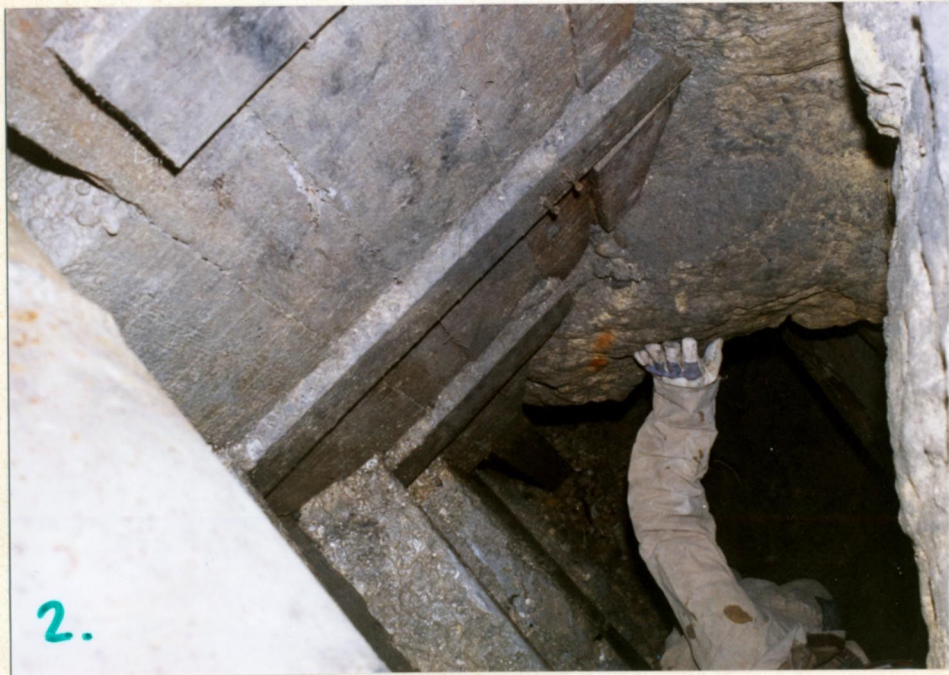
Betengyürü aljzatbeton, nagyszelvényű csapadékvíz csatorna oldalfala, és a természetes barlangjáratok nyílása.
