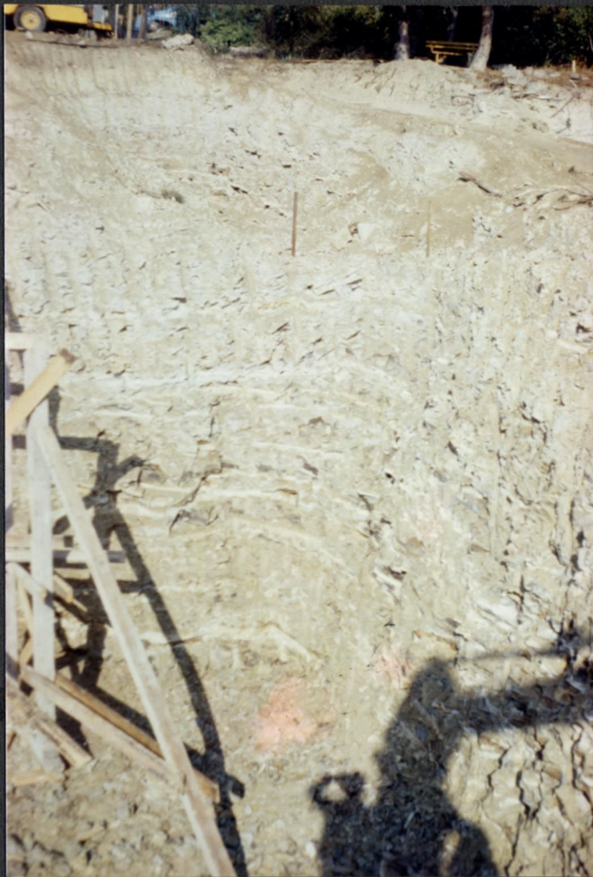
Endrődi S. u. 8-8a. Mélyalapozás agyagos kifejlődésű Budai Márgában. A felvételt Kecsis Á. készítette.
