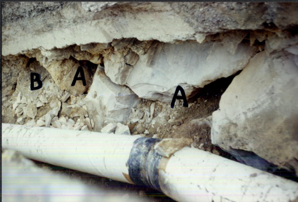
Omladékzóna a Bimbó út 58 előtt. A: az omladék kioldott hézagai B: tömedékelt járat A felvételt Kecsis Á. készítette.
