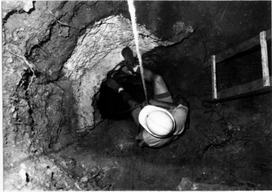
3. fotó a kútgyűrűk helyét véséssel alakítottuk ki
