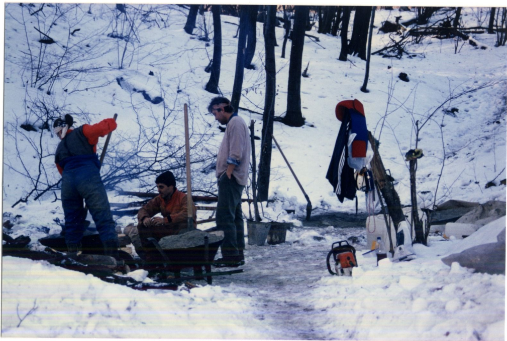
2. Lánér bejárati szakasz betonozás télben, fagyban Kovács Attila
