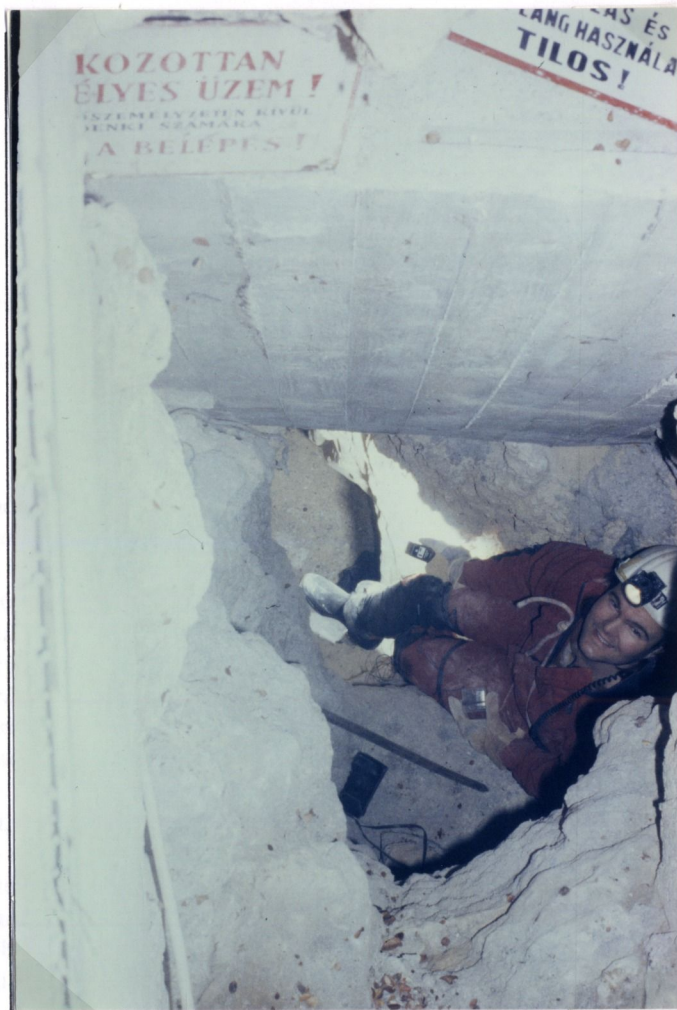
13. fotó (192/11 Tóth) A bejárati akna kész betonozása
