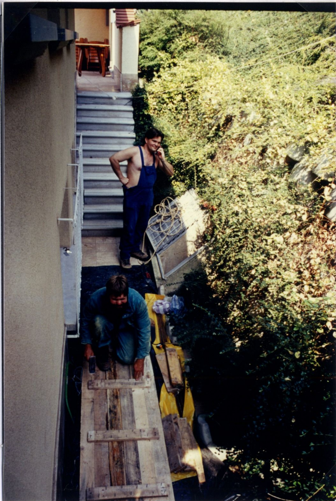
10. fotó (191/1 Tóth) A bejárati akna zsalujának készítése. A mélyben dolgozókkal telefonon tartjuk a kapcsolatot.
