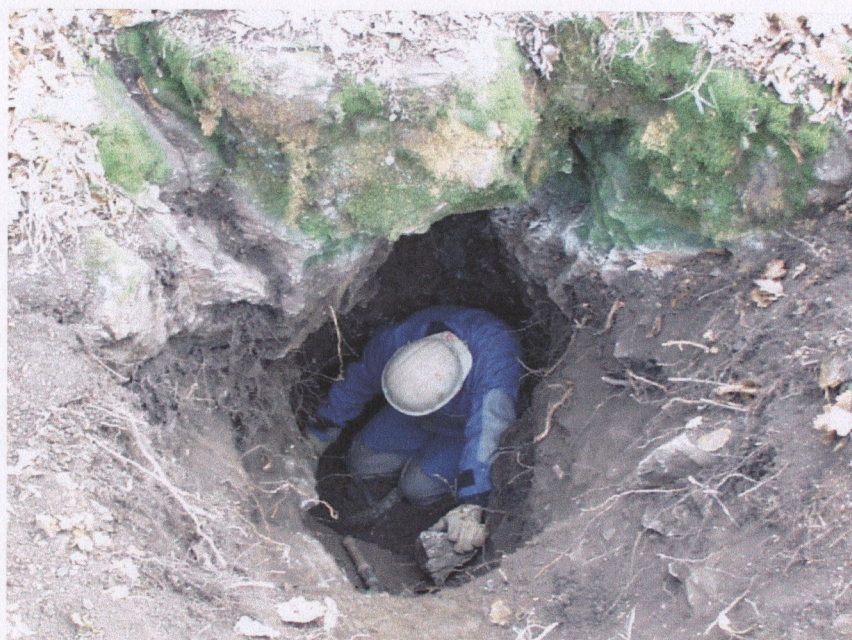
A bejárat akna mélyítése
