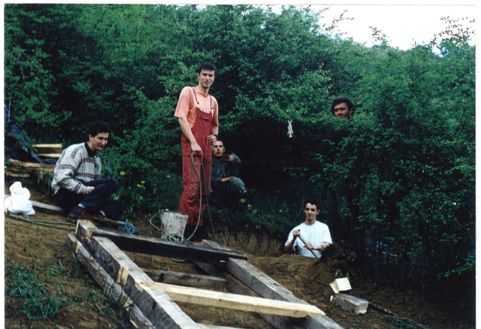
53. fotó Mérőakna ácsolat beépítése
