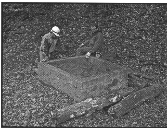
Az árvízbiztos, falazott bejárat
