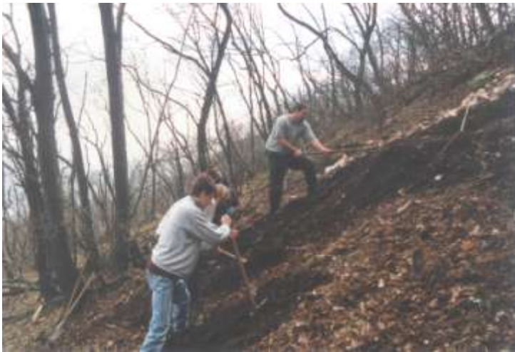
Először a felső humuszréteget termeltük le.
