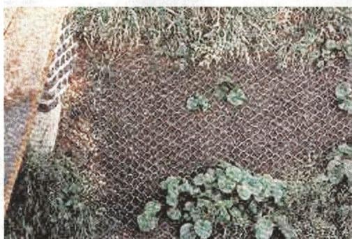
2. kép Duna magaspart (Göd) védelme rőzsekévé-élőcserjés-netlonhálós kombinációval, földtakarás-füvesítés után.
