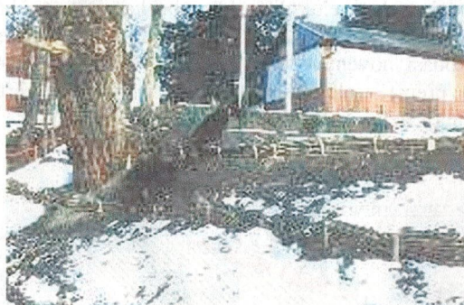
3. kép Duna magaspart védelme rőzsekévé-szekrényműbe ültetett élősvénnel. 1992. ős
