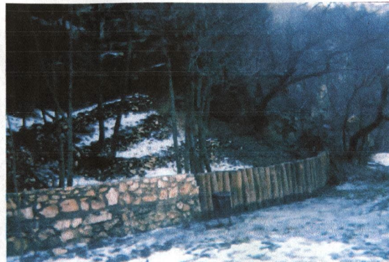
7. kép Kő-föld szekrénymű élőcserje beültetéssel, törmelékerózió megkötésére. Pálvölgy, 1999. ősz
