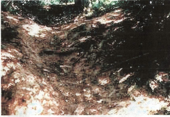
8. kép Rönk-föld szekrénymű töbörben vízmosás fej biztosítására. Alba Regia-bg. 1998. nyár
