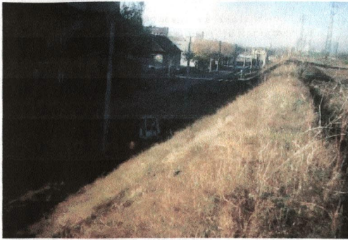
27. kép Kőbánya felső állomás. Rézsű szivárgó építése (nyitott felső övák)
