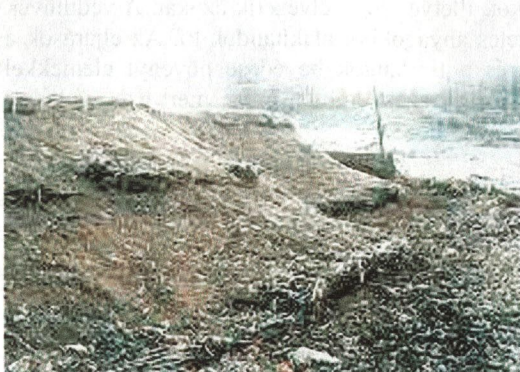
2. kép Duna magaspart (Göd) védelme rőzsekévé-élőcserjés-netlonhálós kombinációval, földtakarás-füvesítés után.
