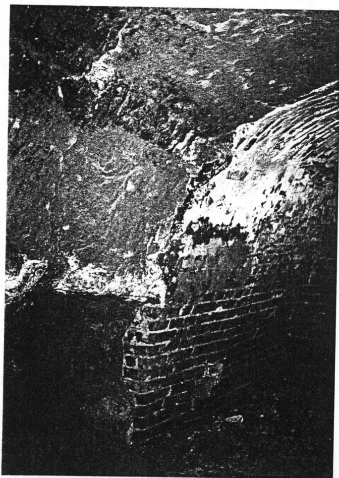
A pince első 2,5 m-e téglaival burkolt, a bel- ső rész már homokkőbe van faragva
