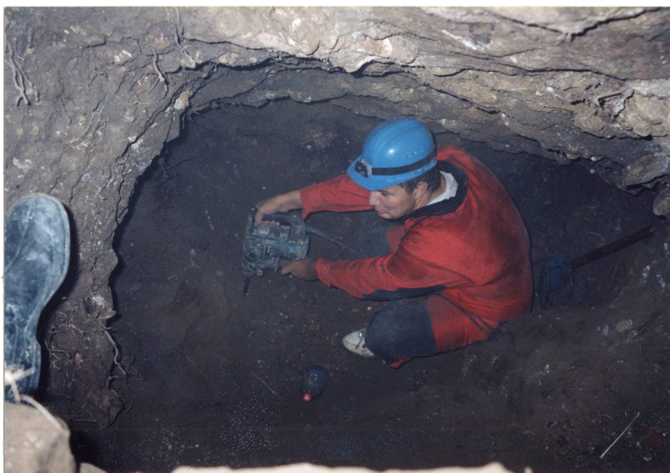
A GN-töbör aknájában az áthalmozott kemény lösz- ben sokszor csak vésőgép segítségével lehet elő- re haladni /E.I./
