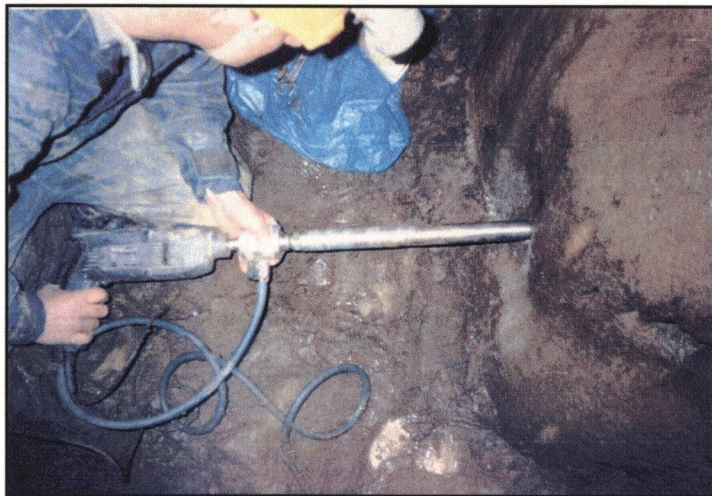
15. ábra. Mintavételezés a Búboskemencéből
