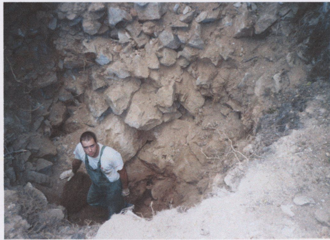
Aztán elég rémisztően mély lett a gödör az omladékban, mire befejeztük a bontást. Innentől már ácsolni kellene.
