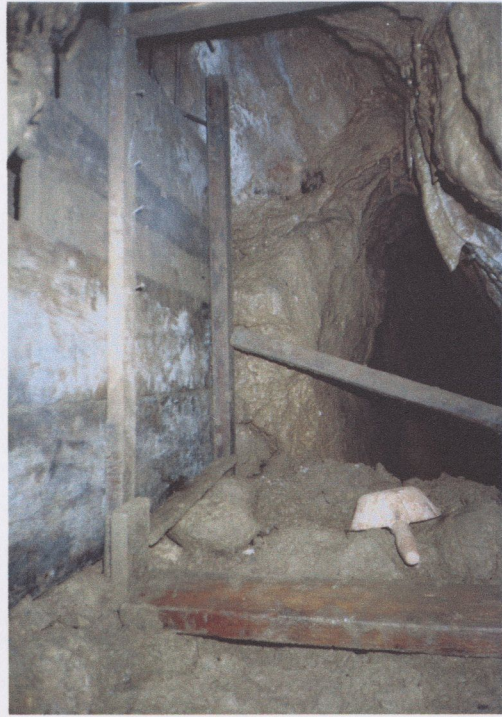
A beszaluzott átjáró betonozás közben.
