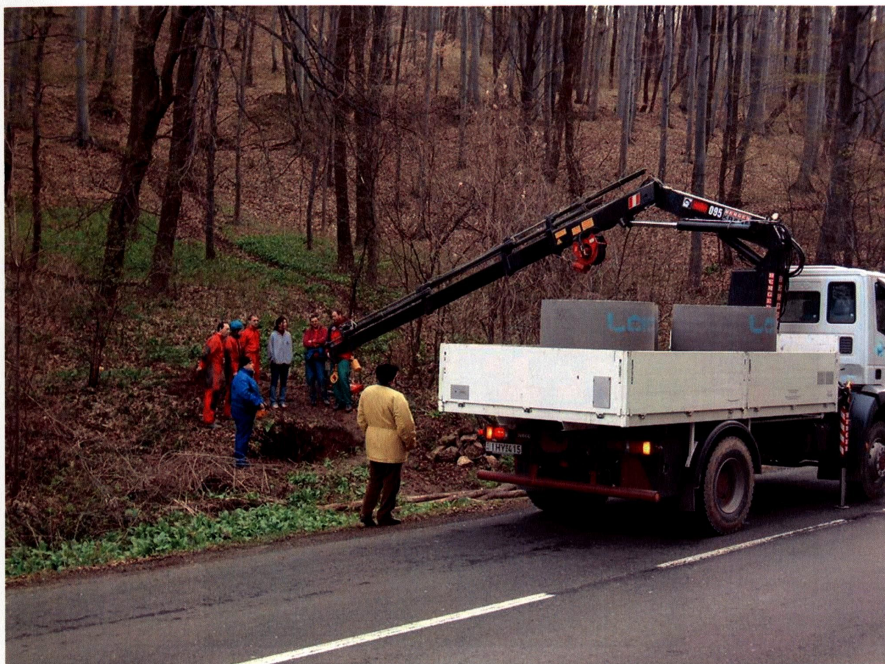
- a Rumba-barlang lezárása -
