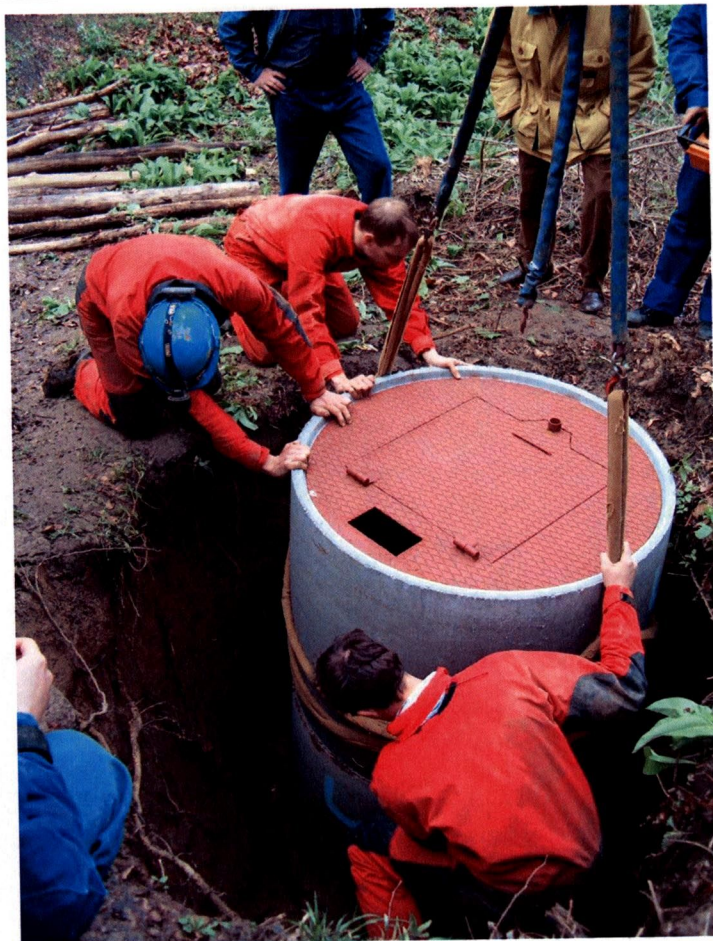
- a kútgyűrűk elhelyezése a Rumba-barlangnál -
