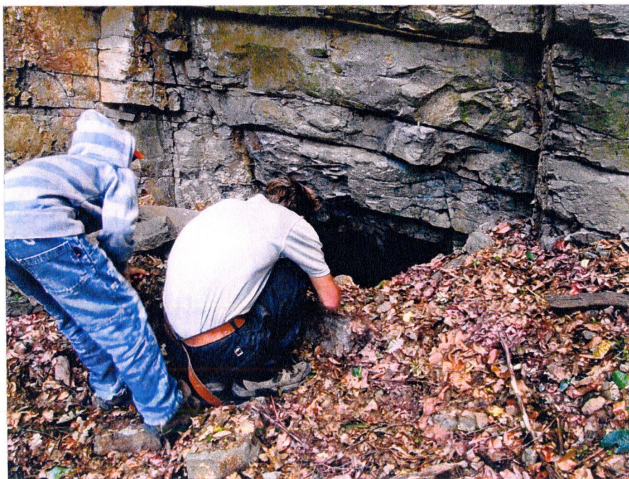
A Nagy-völgyi-táró bejárata /B.L./
