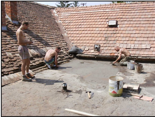
A lapos tető szigetelése – a födém javítása, aljzatkiegyenlítés Fotó: Zalán Béla
