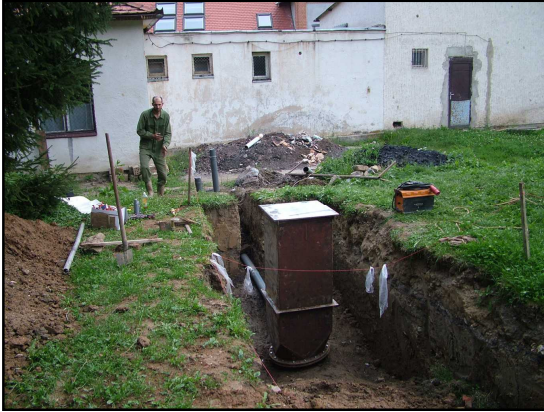
A „Nautilus” új helyén összeszerelve, betemetésre vár Fotó: Ollé Péter
