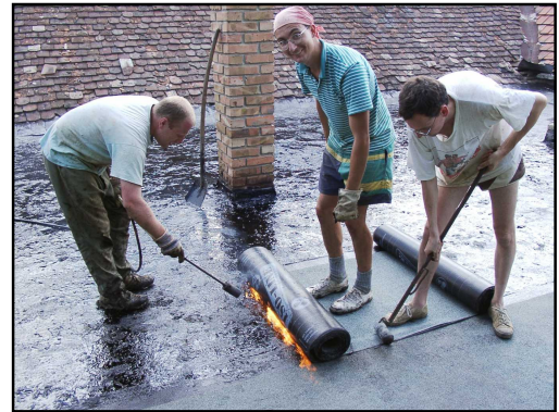
A lapos tető szigetelése – nehézlemez fektetése Fotó: Zalán Béla
