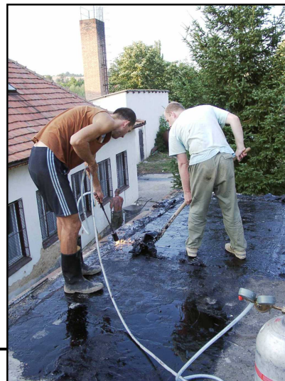
A lapos tető szigetelése – a felület megtisztítása Fotó: Zalán Béla
