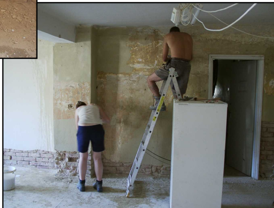
„Vakolatverés” a fürdőben, festékrétegek eltávolítása a nagyszobában
