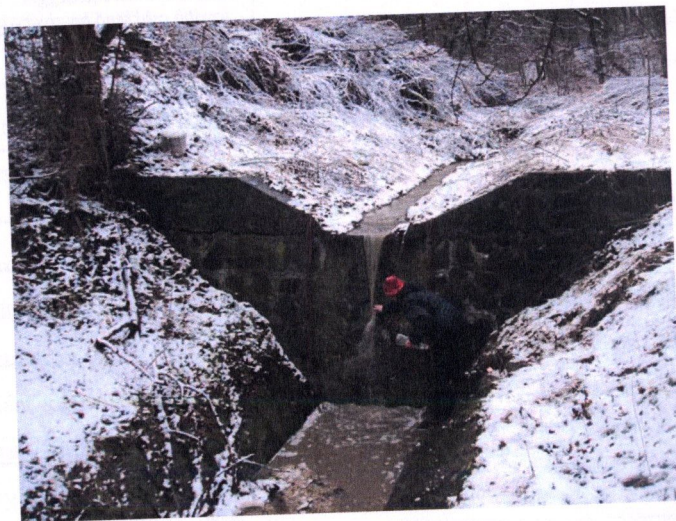
3. kép A Szép-völgy Erdei lak feletti szakasza
