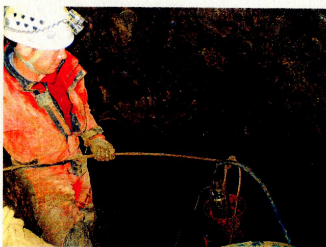
A szivattyú behelyezése a szifon vizébe.
