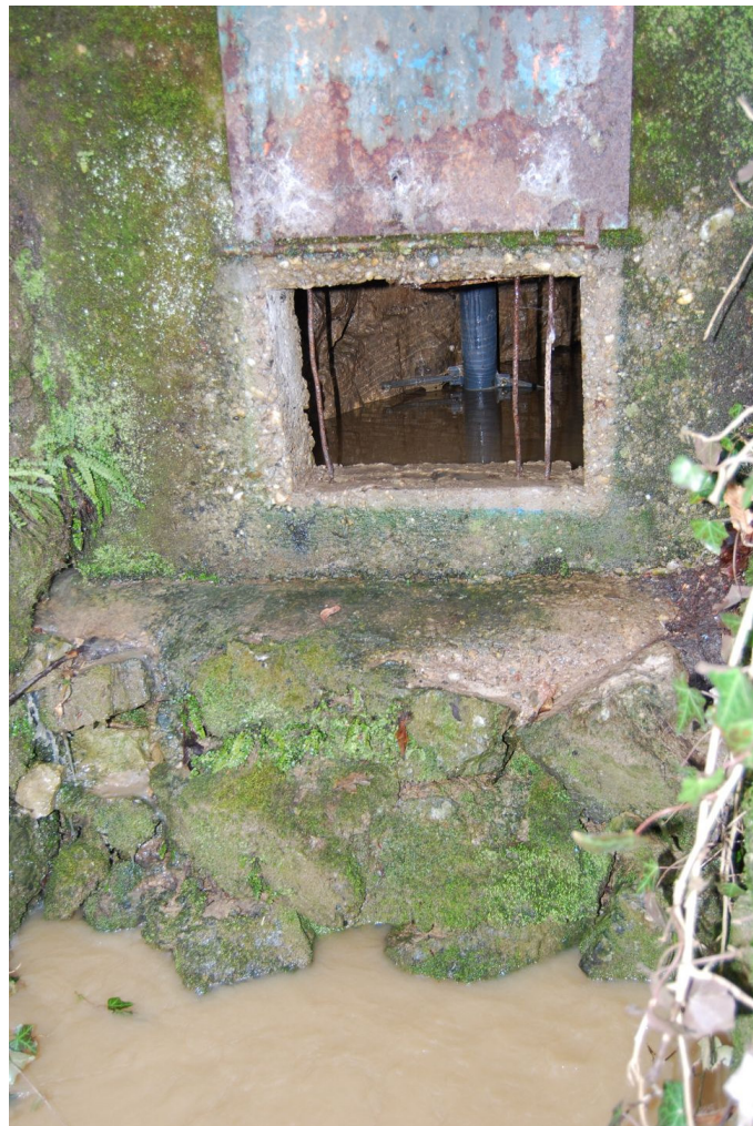
A februári áradás képei. A rakott kőfal bal felső sarkánál látható vízmegjelenés jelzi a fal mögötti, visszaduzzasztott víz szintjét – amúsz is ezt a vízszintet méri
