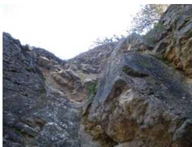
A bányafalat védő acélháló a bárángbejárat fölött.
