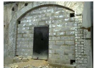
A barlang levegős terméhez vezető mesterséges táró bejárata.
